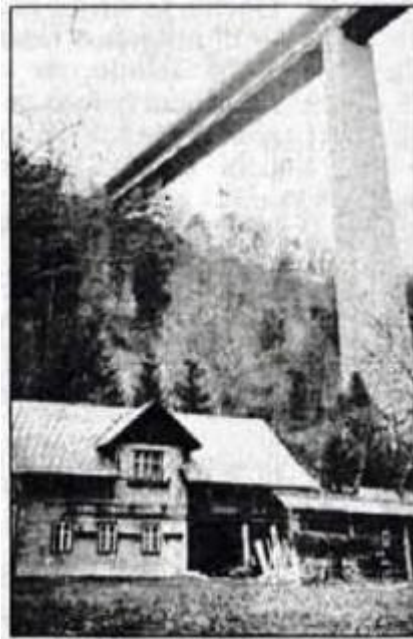
Hiša pod viaduktom
